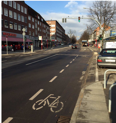
Die Fuhle nach der Sanierung, Foto: AK
